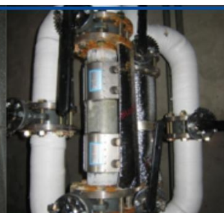
Ugradnja inspekcijske točke
