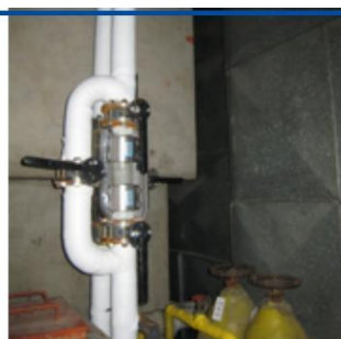
Ugradnja inspekcijske točke
